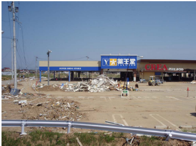
本吉町から気仙沼駅へ向かう国道沿いの様子。海岸側の建物は崩壊しているが国道を挟んだ向かい側の建物はほとんど被害を受けていない様子がわかる。わずかな距離、段差が明暗を分けている。
